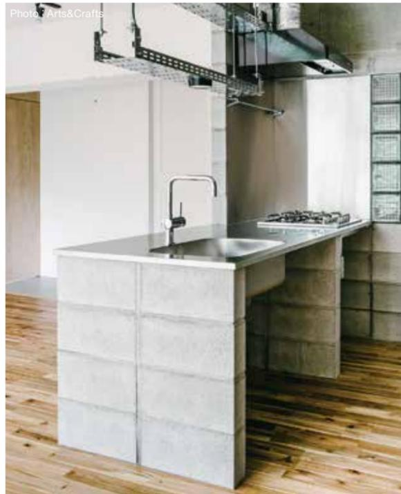
土台をコンクリートブロックで製作した事例。
