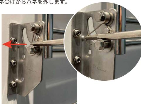
マイナスドライバーか指で、バネを矢印方向に押してバネを外します。
