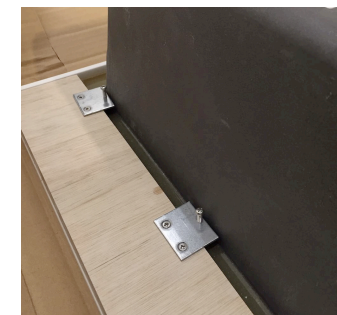
アンダー設置の場合、写真のような補強金具を準備して併用いただくと安心です
