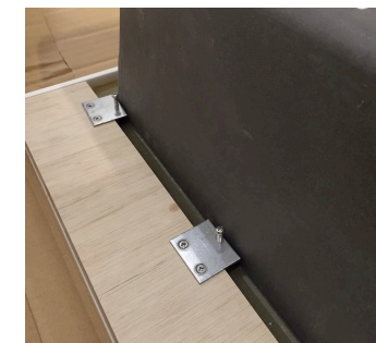
アンダー設置の場合、写真のような補強金具を準備して併用いただくと安心です
