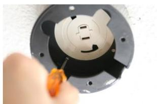
4. 台座を天井ローゼットにかぶせて先ほど選んだネジで取付けます。
